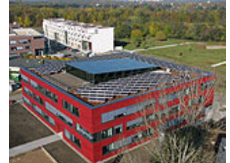
Detailansicht Firma Econcern GmbH
